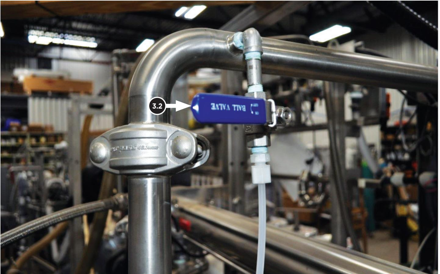
3.2 Valve de prise d'air et de drainage de la plomberie acheminant l'eau à la pompe de suralimentation.
