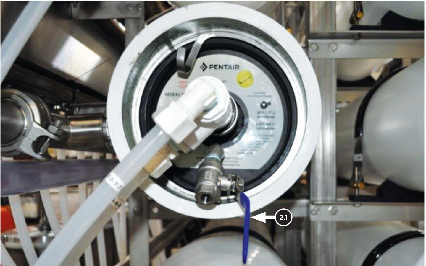
2.1 Valve de drainage du caisson et de ses caissons supérieurs.
