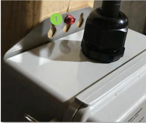
Figure 41 : Vis à tôle sur tuteur pour installation d'un transmetteur vacuum
