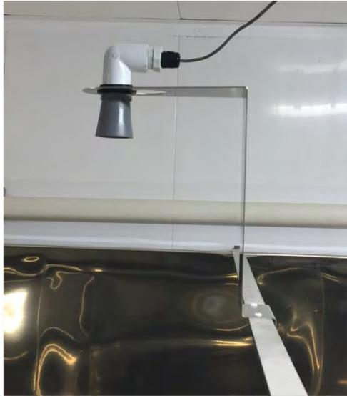
Figure 45 : Capteur de niveau de bassin sonar installé
