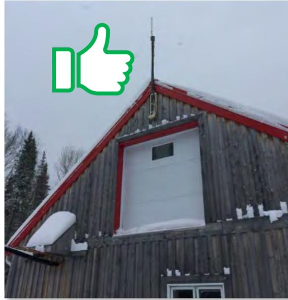
Figure 80 : Antenne sur un bâtiment bien installée
