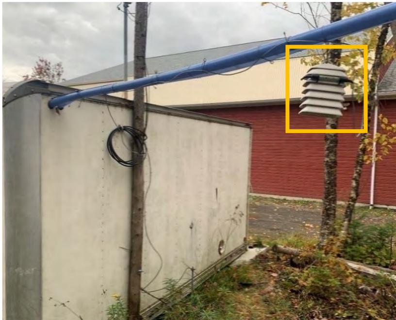
Figure 73 : Sonde de température extérieure installée
