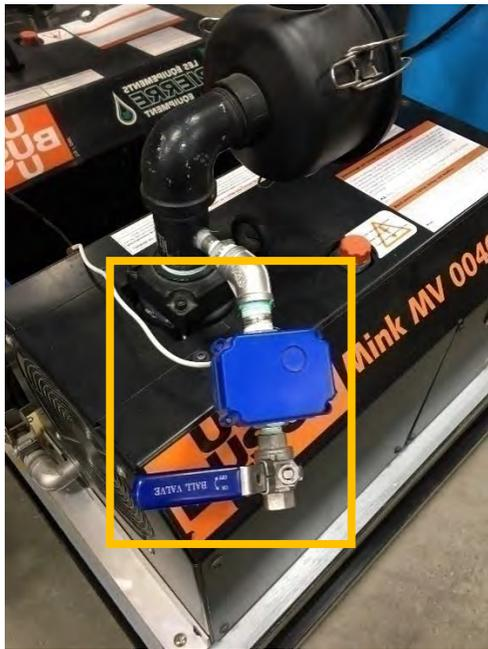
Figure 70 : Valve de prise d'air installée
