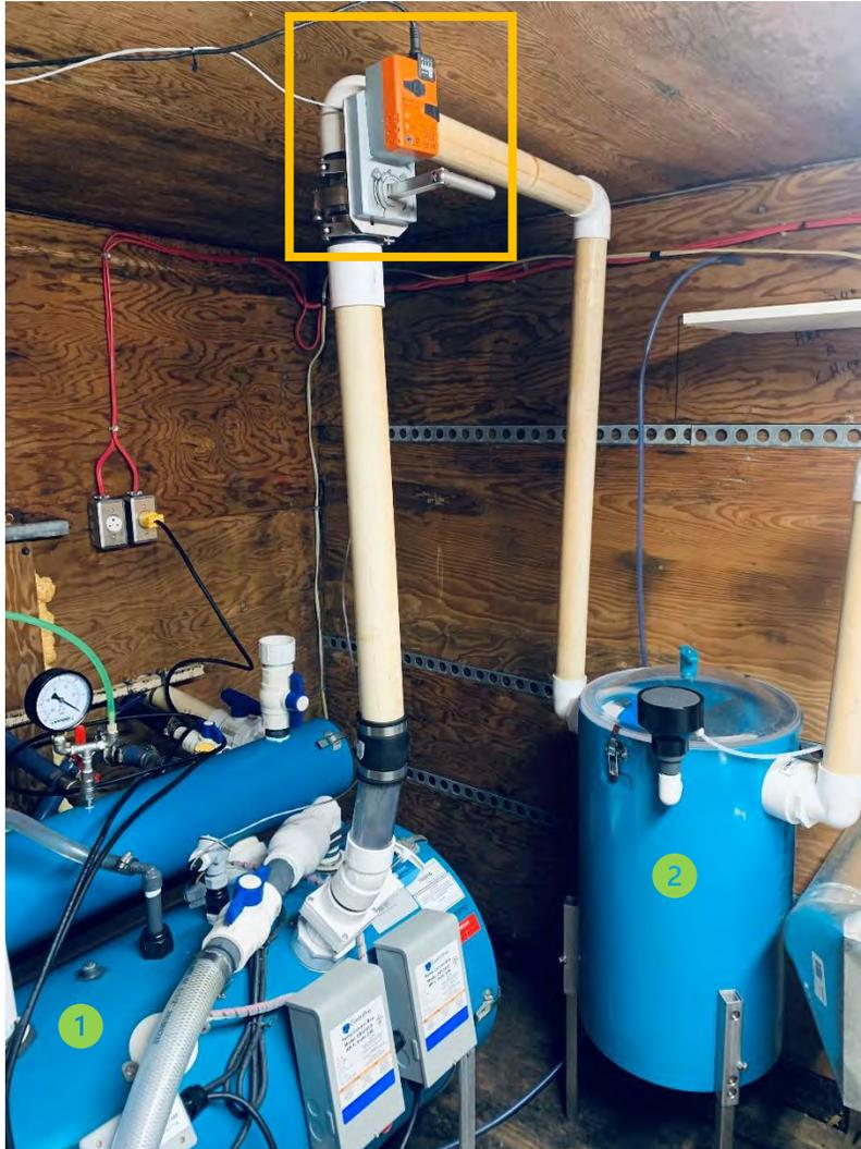
Figure 59 : Valve de modulation du vacuum installée
