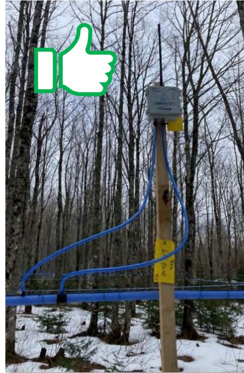
Figure 43 : Transmetteur vacuum bien installé
