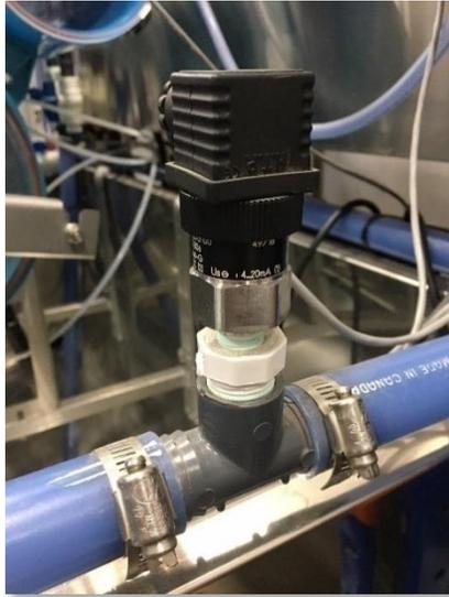
Figure 63 : Capteur de pression vissé installé
