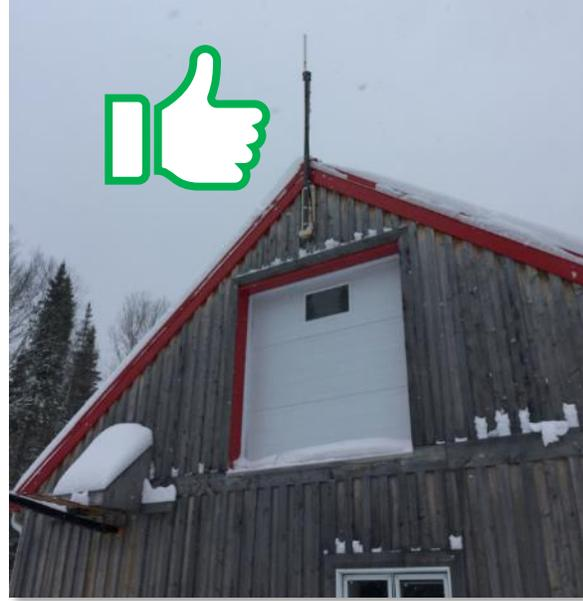
Figure 119 : Antenne sur un bâtiment bien installée
