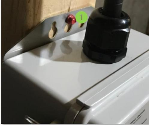
Figure 46 : Vis à tête sur tuteur pour installation d'un transmetteur vacuum
