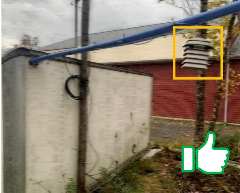
Figure 105 : Sonde de température extérieure bien installée
