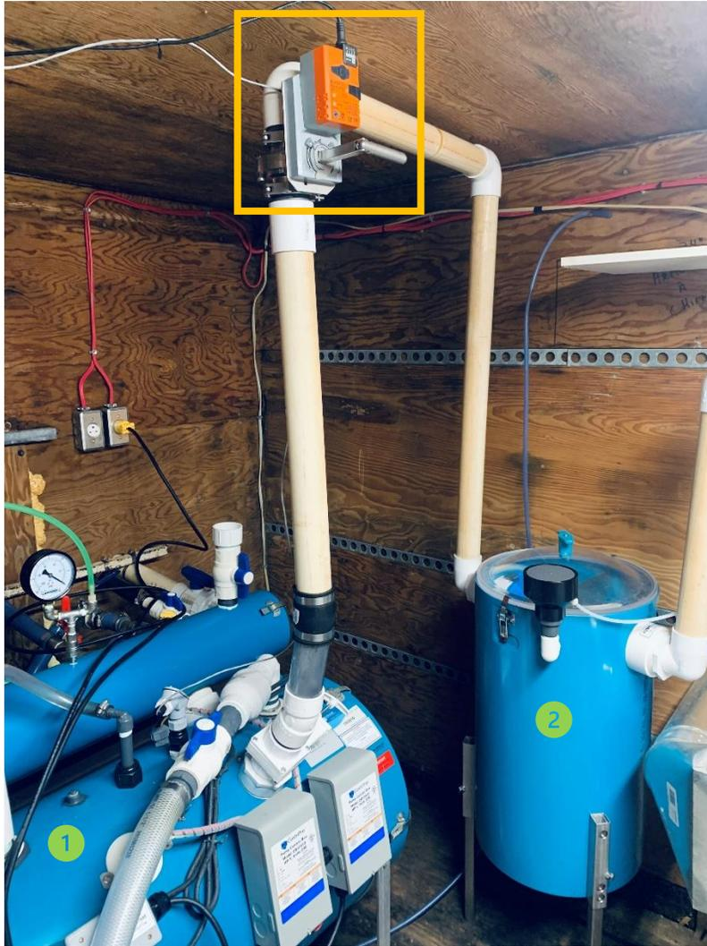
Figure 84 : Valve de modulation du vacuum installée
