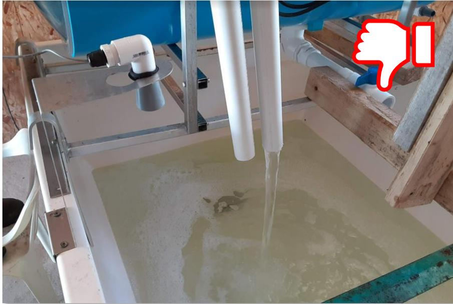
Figure 58 : Capteur de niveau de bassin par ultrason mal installé
