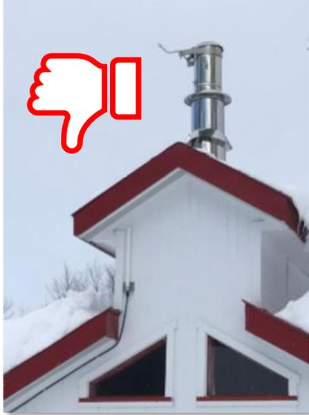
Figure 118 : Antenne sur un bâtiment mal installée
