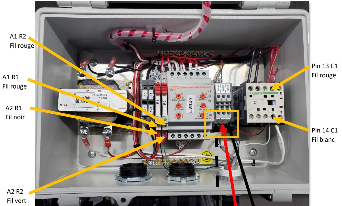
Figure 92 : Branchement des électrodes dans le contrôle de pompe à eau
