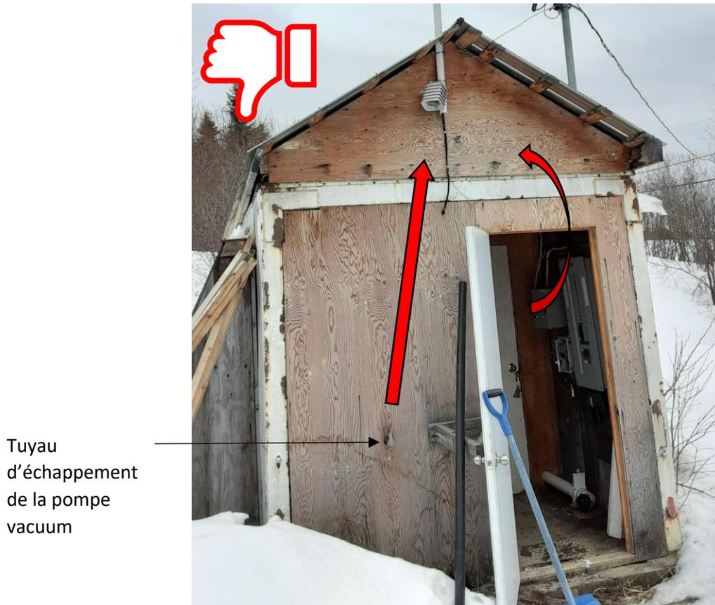
Figure 106 : Sonde de température extérieure mal installée
