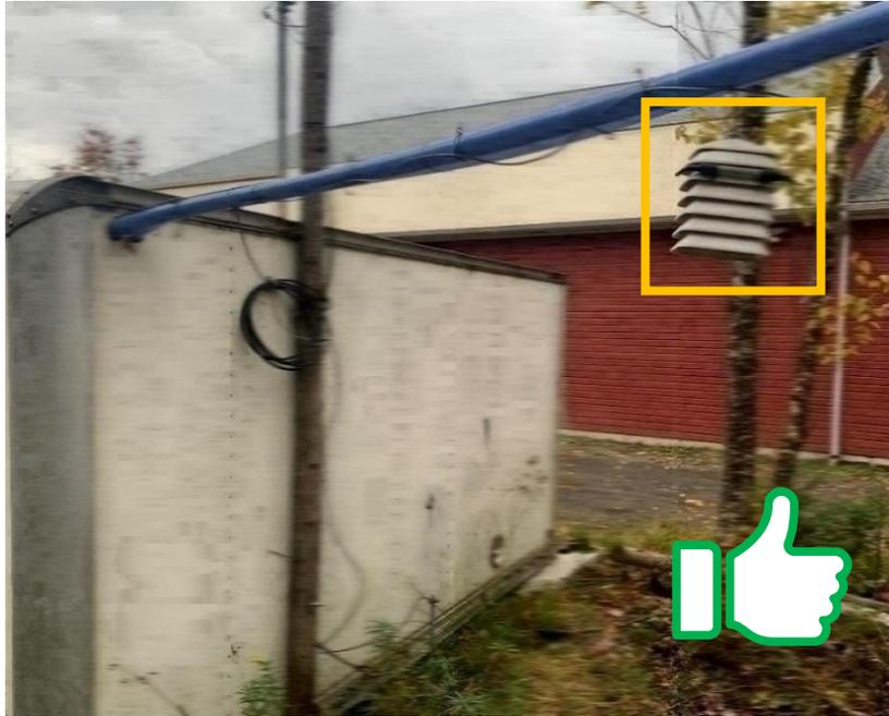
Figure 107 : Sonde de température extérieure bien installée
