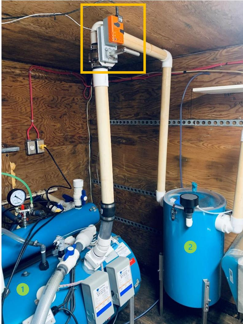
Figure 86 : Valve de modulation du vacuum installée
