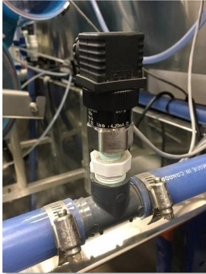
Figure 64 : Capteur de pression vissé installé
