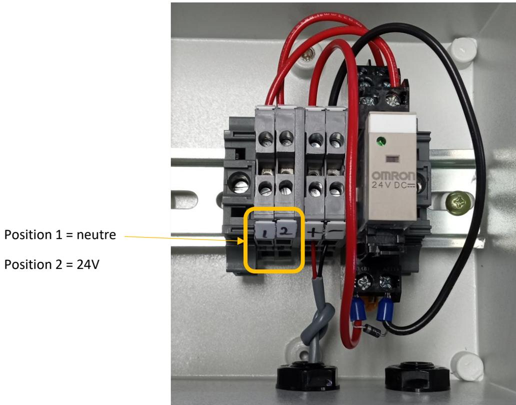
Figure 78: Vue intérieur d'une boîte de relais de départ magnétique de pompe vacuum
