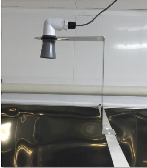
Figure 57 : Capteur de niveau de bassin ultrason installé
