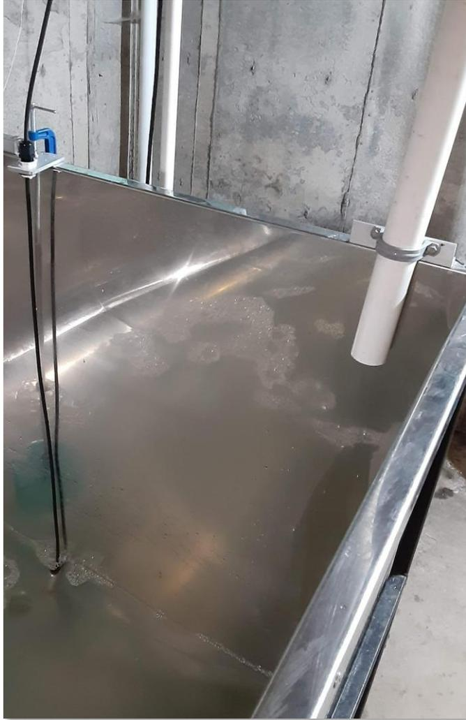
Figure 65 : Sonde submersible installée
