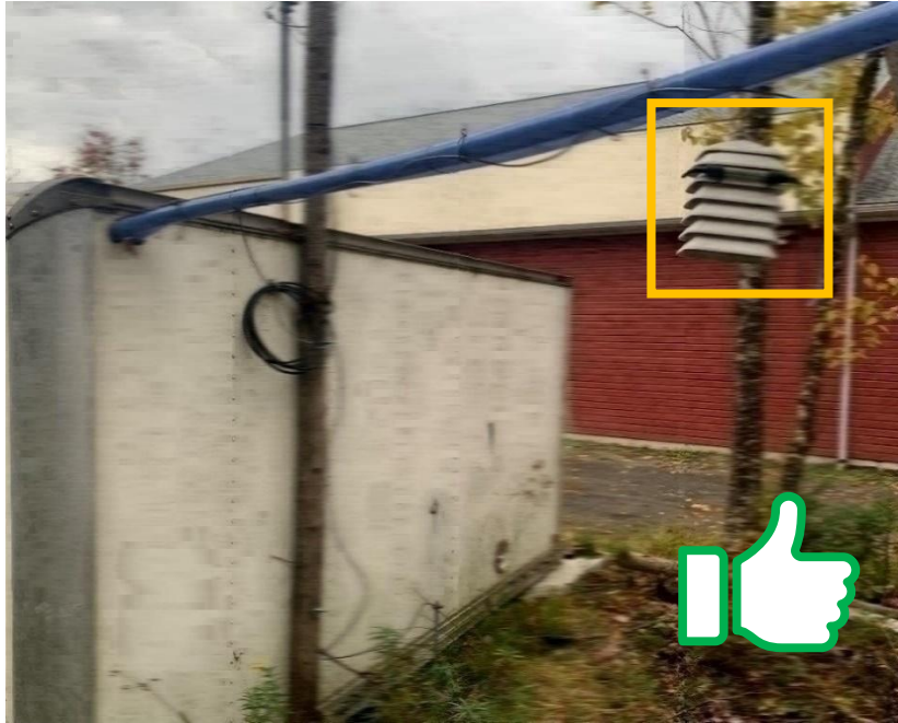
Figure 107 : Sonde de température extérieure bien installée
