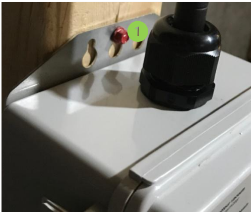
Figure 46 : Vis à tête sur tuteur pour installation d'un transmetteur vacuum
