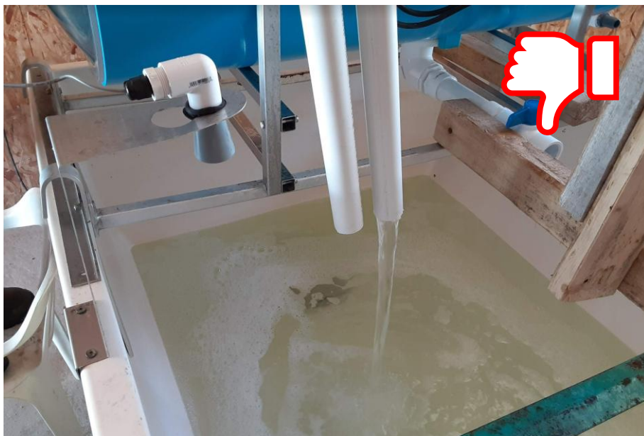
Figure 59 : Capteur de niveau de bassin par ultrason mal installé
