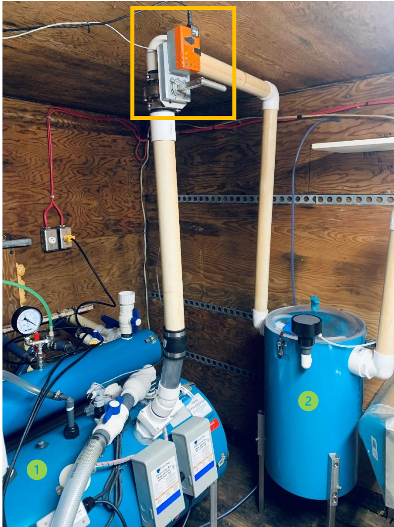
Figure 86 : Valve de modulation du vacuum installée
