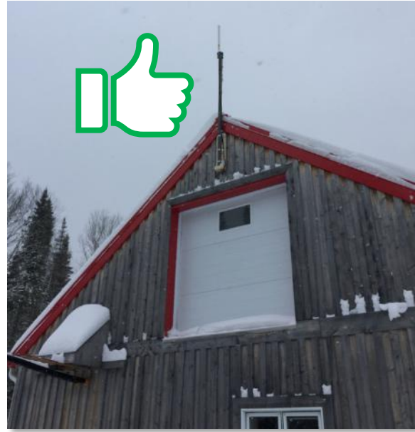
Figure 121 : Antenne sur un bâtiment bien installée
